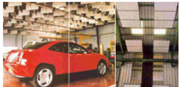
4.19. ábra: Autószerviz – A terem hangelnyelése © Yves Cousson. Rendelkezésre bocsátotta: INRS – Franciaország
