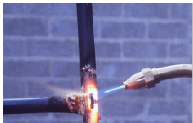
4.4. ábra: Építőipar – Zajmentes hegesztőpisztoly használata © Yves Cousson. Rendelkezésre bocsátotta: INRS - Franciaország
